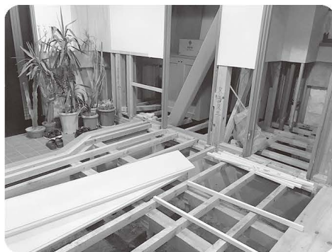
床板がない状態
