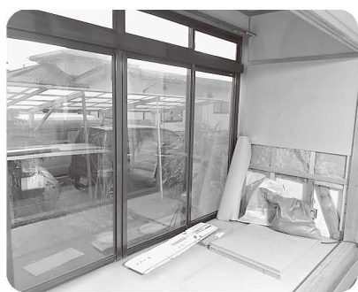
窓の手前、床の板が張れた
