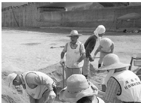
岩手県大槌町にて海岸での瓦礫撤去
