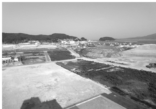
現地では、高台の造成がすすんできています。
